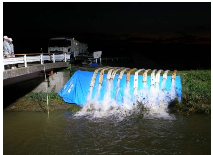
夜間における排水作業 涌谷町 新名鱈地内
