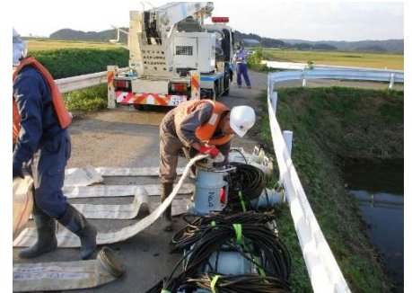
排水ポンプ設営 涌谷町 新名鱈地内
