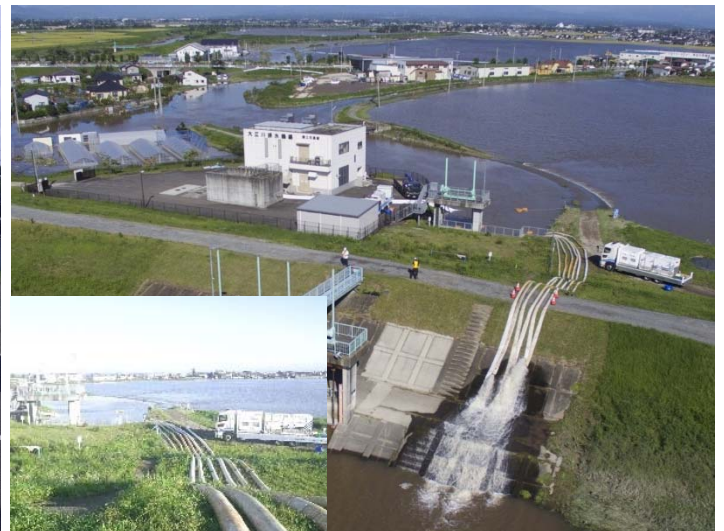
排水作業 大崎市古川米袋水押地内(大江川排水機場)
