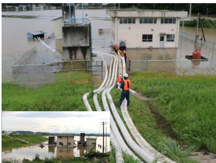
排水作業 大和町 落合三ヶ内地内(三ヶ内排水機場)
