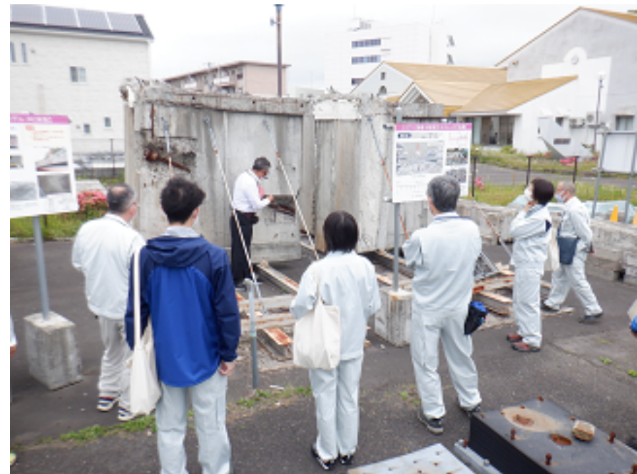
被災したPCT桁 グラウト注入について
