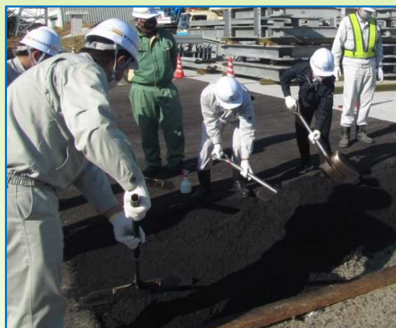
土木講習会（第3回）： 実習 人力舗設
