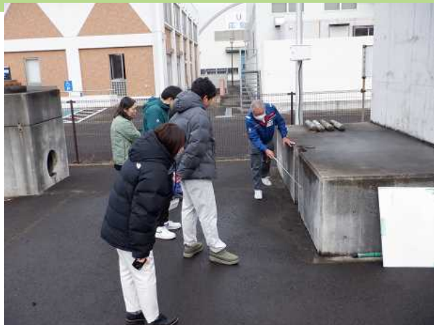
不適切施工について
