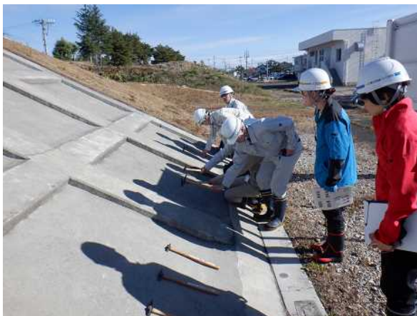
打音による護岸の空洞化の確認
