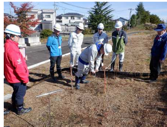
貫入棒による堤体の緩みの確認
