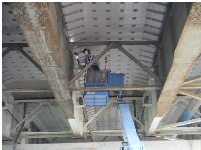
▲橋梁点検の様子
