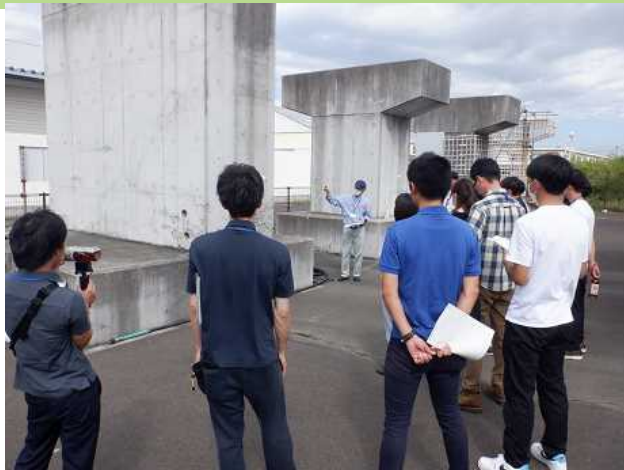
不適切施工について
