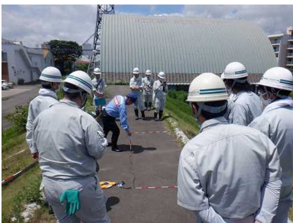
堤防の亀裂の計測
