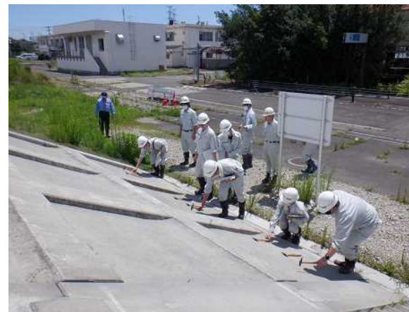
打音による護岸の空洞化の確認
