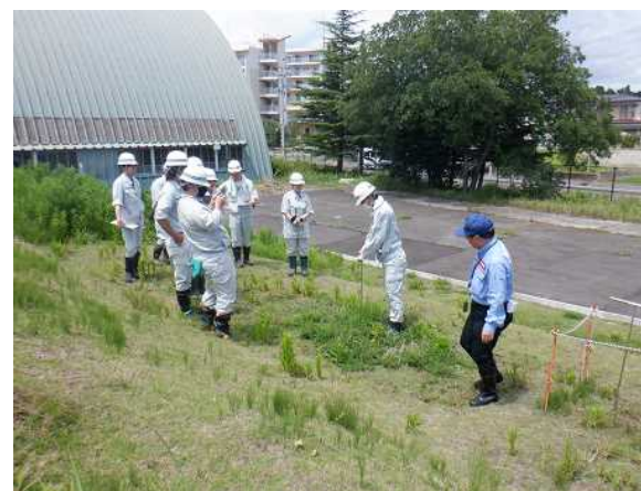
貫入棒による堤体の緩みの確認
