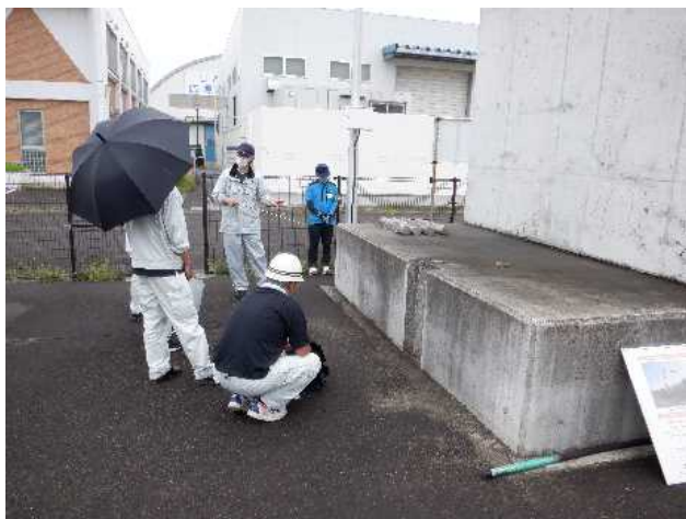
不適切施工について
