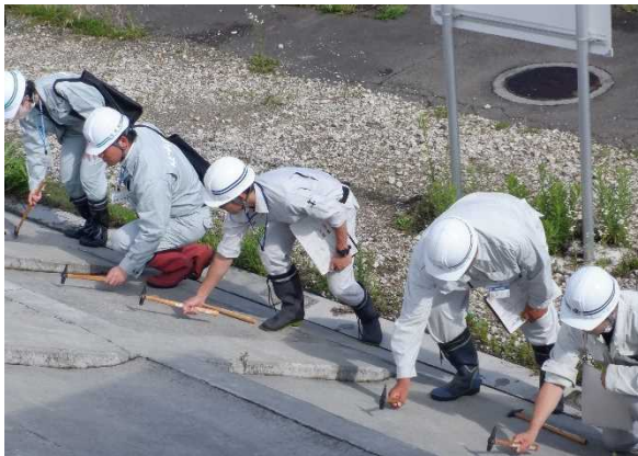
打音による護岸の空洞化の確認
