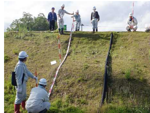
堤防のはらみ出し・寺勾配の計測
