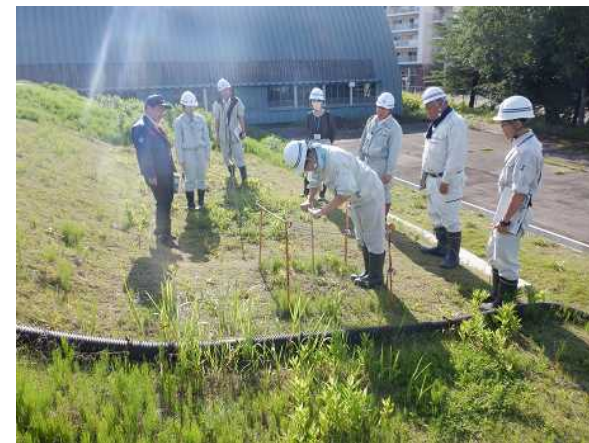
貫入棒による堤体の緩みの確認
