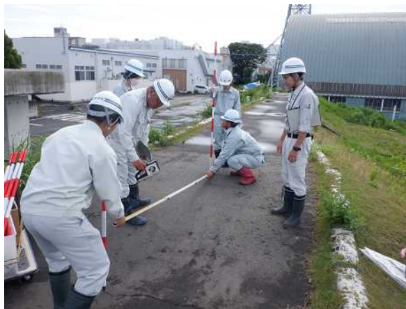
堤防の抜け上がりの計測
