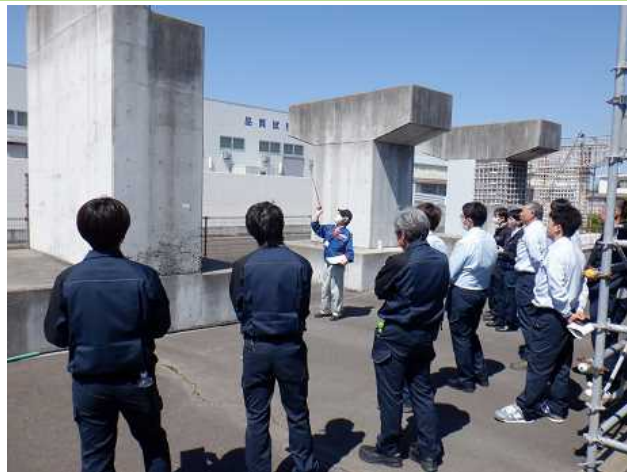
不適切施工について
