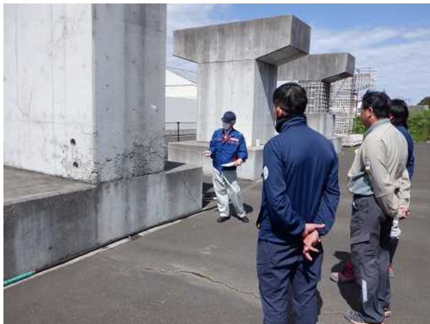
不適切施工について
