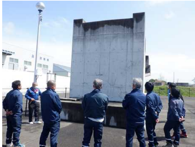
不適切施工について
