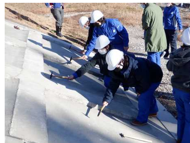
打音による護岸の空洞化の確認
