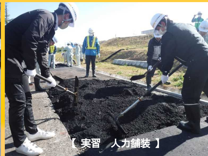
【実習 人力舗装 （合材温度測定）】
