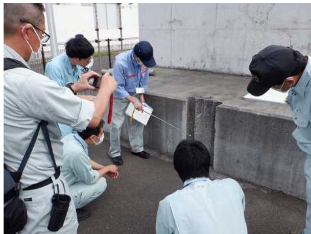
不適切施工について
