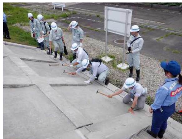
打音による護岸の空洞化の確認
