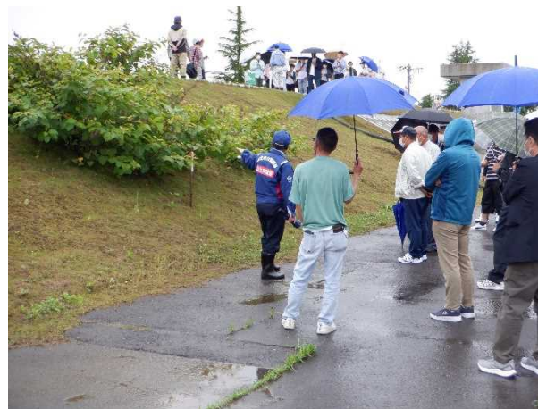
堤防植生異常と裸地化について
