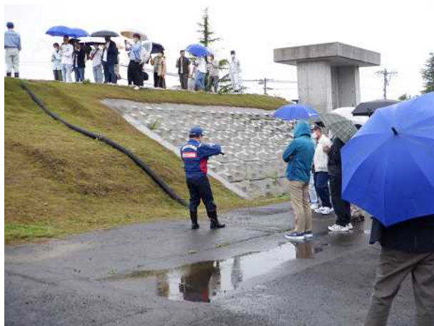
堤防法面の変状(寺勾配・はらみ出し)について
