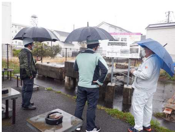
劣化した床版について
