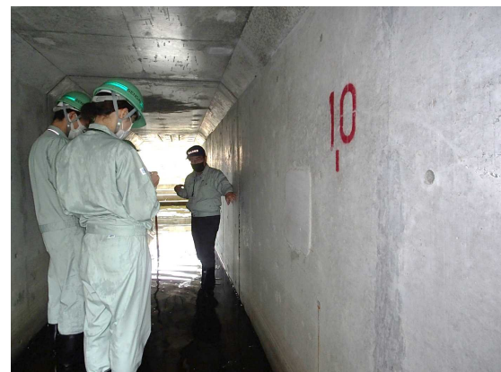
樋管内部のひび割れ調査を体験
