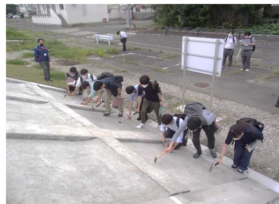
法枠護岸の空洞化調査(打音調査)を体験
