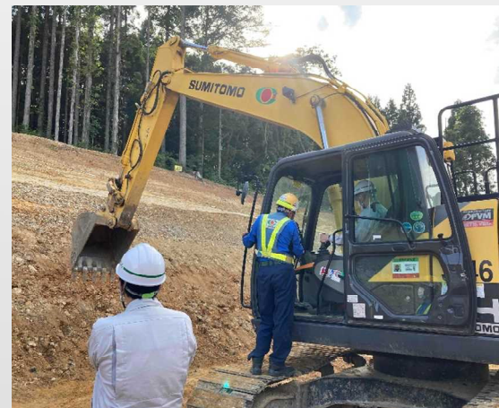
ICT建設機械の操作
