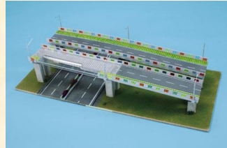
作品名 クリア歩道付PC中空床版橋 (耐震構造) 福島県立福島明成高等学校 鈴木 智弘 清野 隼
