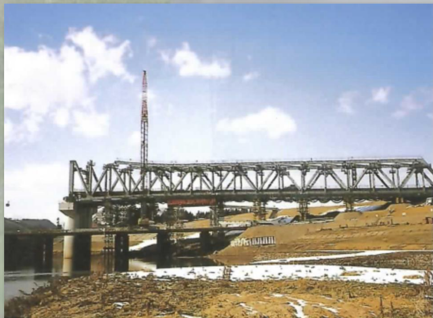
P1橋脚まで架設された状況
