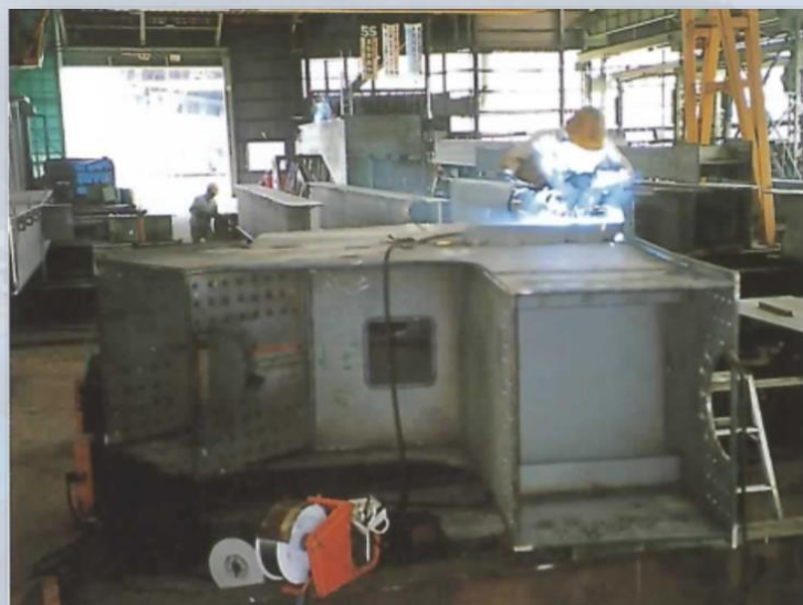
切り出したパネルを溶接
