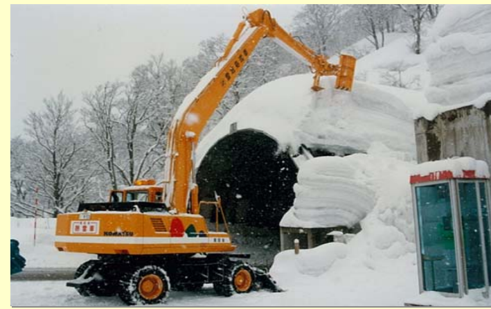
平成5年 雪庇処理機 (トンネル抗口処理状況)
