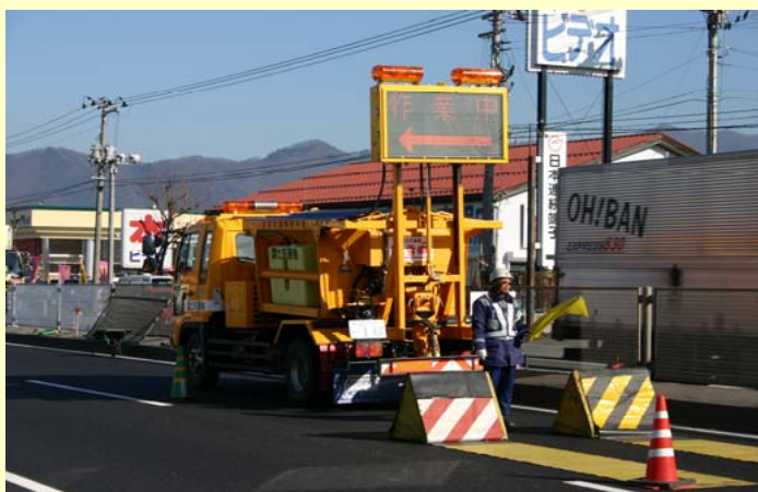
平成15年 除雪機械の通年化活用 (凍結抑制剤散布車の工事標識車への活用)
