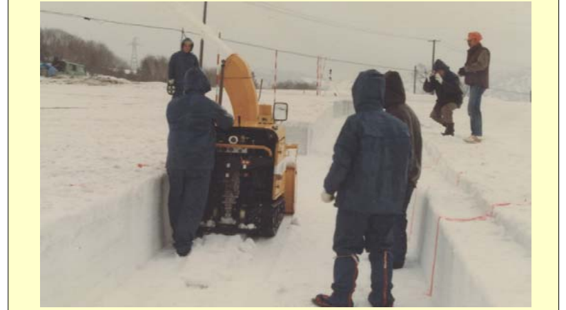
昭和55年 SC-3型小形除雪機 性能試験
