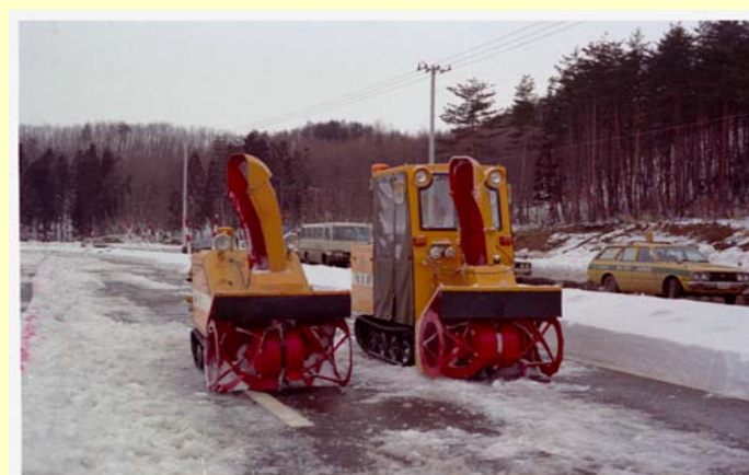
昭和56年 小形除雪機と乗員式小型除雪車
