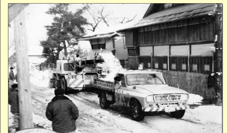
昭和39年 市街地運搬排雪作業中の SL-3型スノーローダ
