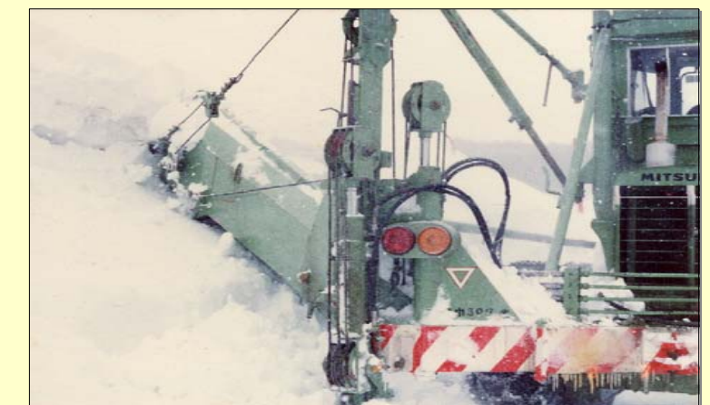
昭和51年 除雪グレーダ装着 マックレイ装置性能試験
