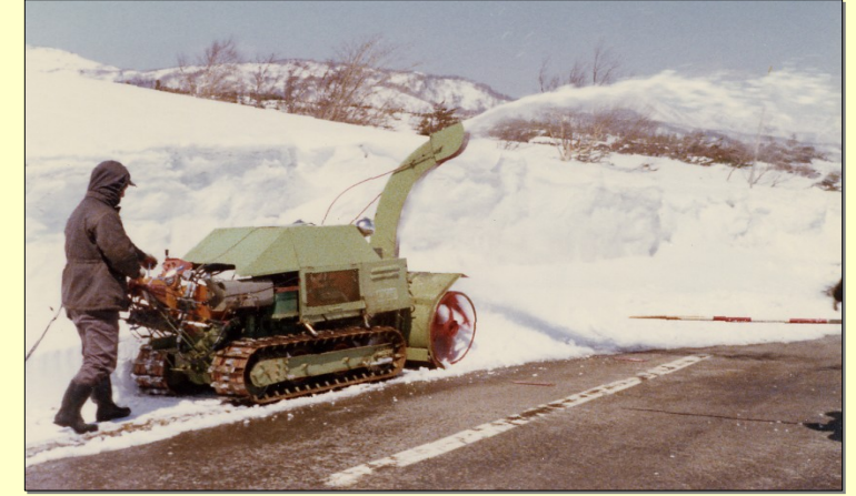
昭和44年 SC-3型小形除雪機性能試験 (蔵王)
