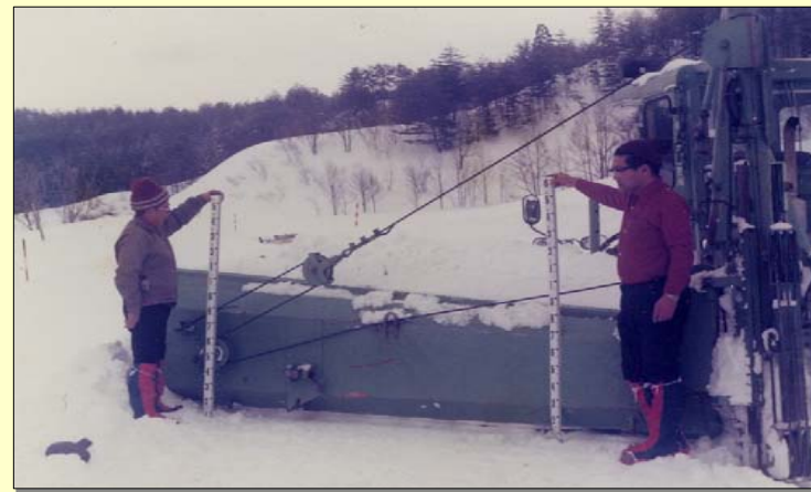
昭和51年 除雪グレーダ装着 マックレイ装置性能試験
