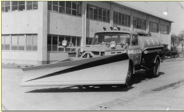
昭和42年 散水車に架装したS-8型スノープラウ
