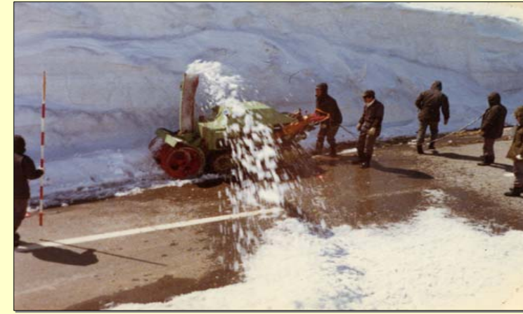
昭和44年 SC-3型小形除雪機性能試験 (蔵王)
