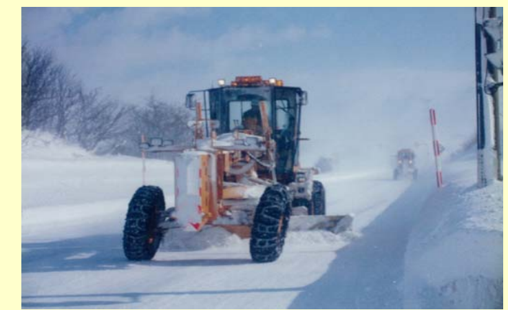
平成9年 視界改善型・ジョイスティックレバー装備 の除雪グレーダ作業状況
