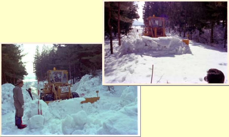
昭和52年 除雪ドーザ性能試験
