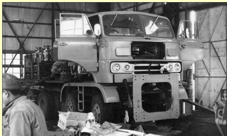
昭和41年 8×8シャシを開発し製作中のツーステージ形 SR250大型ロータリ除雪車
