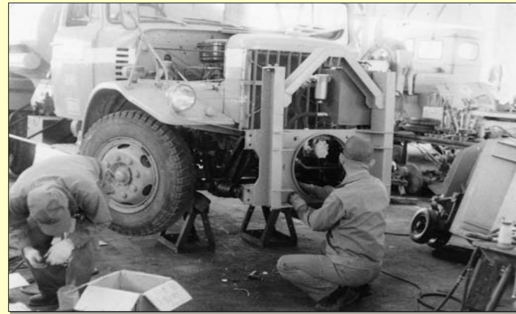
昭和42年 スノープラウ用懸架装置取付け作業
