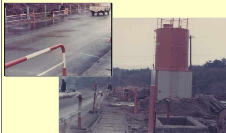
昭和50年 凍結防止剤散布機据付
