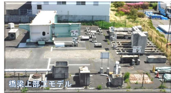
コンクリート構造物
