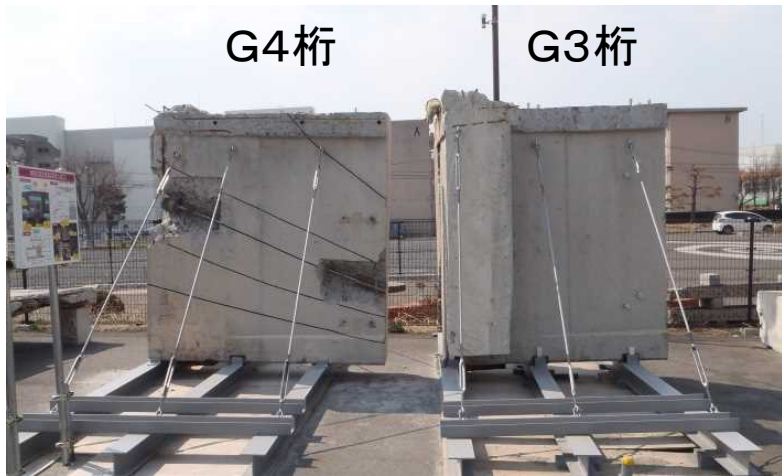
写真一 PCT桁全体写真
