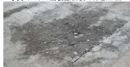
写真 アスファルト舗装撤去後の床版上面
