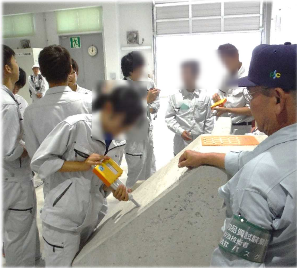
テストハンマーによる 強度推定調査
