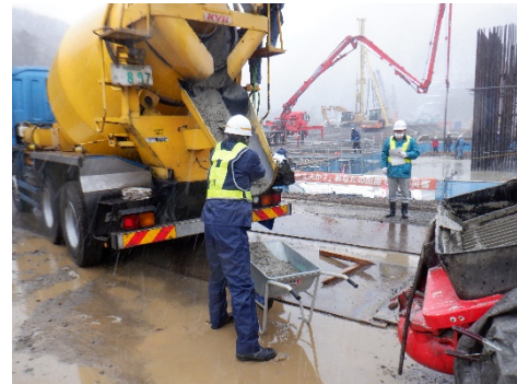
単位水量・空気量測定
