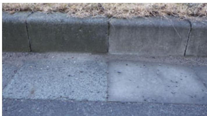
普通コンクリート 再生骨材 M コンクリート
