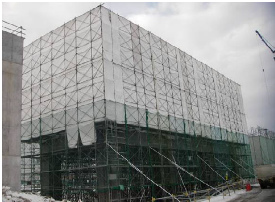
写真 6.4.5 全覆による寒中養生例（高架橋）
