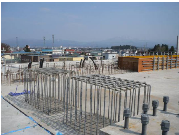
写真 6.4.3 エポキシ塗装状況
