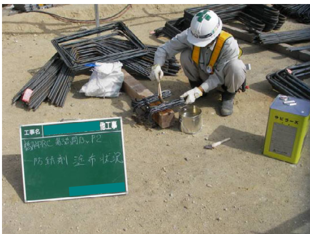
写真 6.4.2 鉄筋の防さび剤塗布状況
