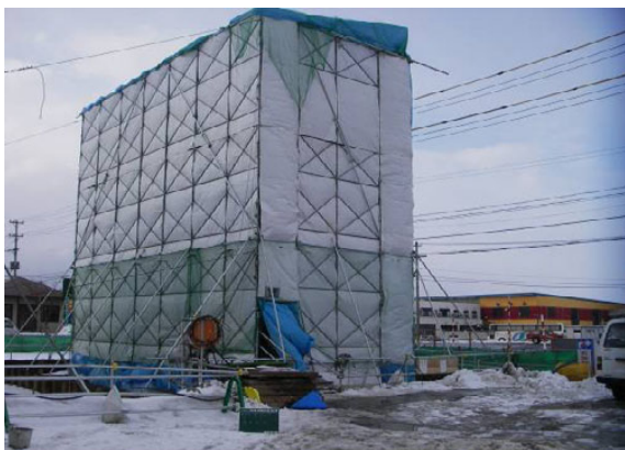
写真 6.4.7 全覆による寒中養生例（橋脚工事）
