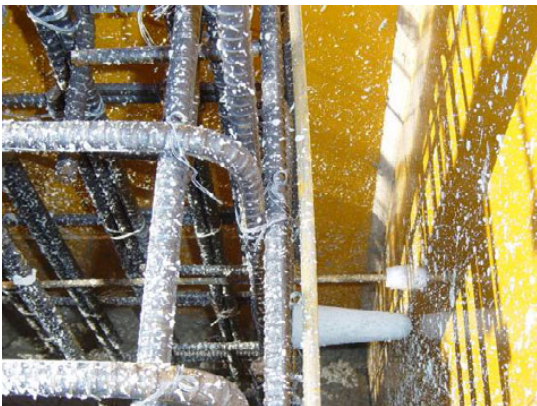
写真 6.4.1 打設前の型枠や鉄筋の清掃状況
