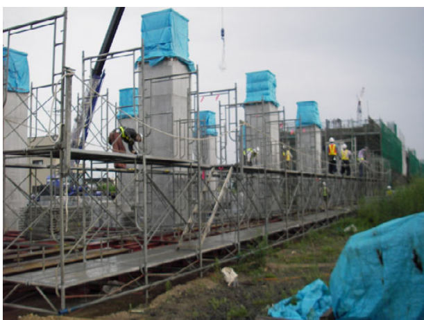
写真 6.4.4 シートによる柱頭部鉄筋の防さび状況
