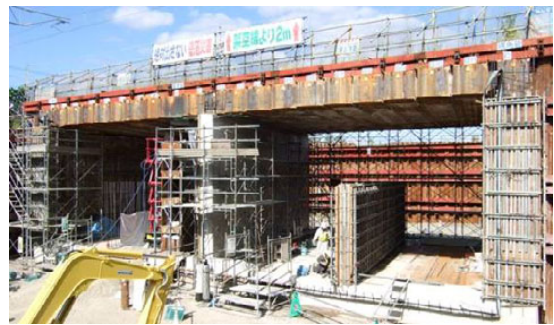
写真 6.4.13 全景（中央が中壁コンクリート）
