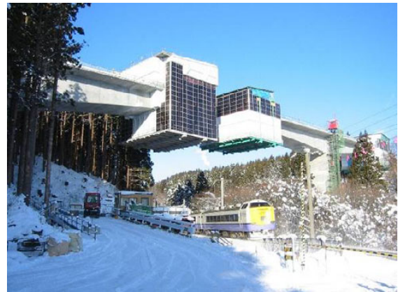
写真 6.4.6 ワーゲンの全覆による寒中養生例（橋梁工事）
