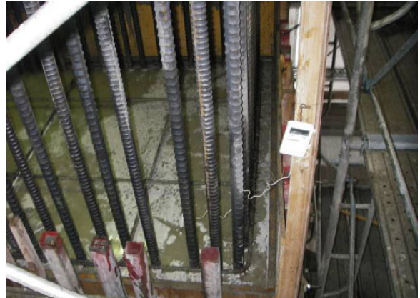
写真 6.4.10 コンクリート温度の測定例
