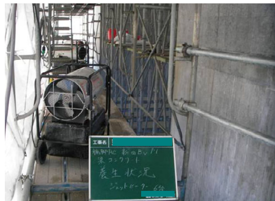
写真 6.4.8 給熱養生例
