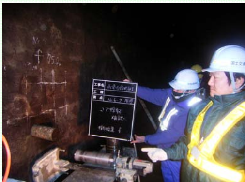
写真2 抜取コア確認状況
