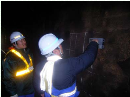
写真1 鉄筋探査状況
