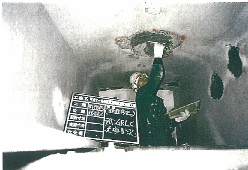
小断面修正工 ポリマーモルタル塗り付け
