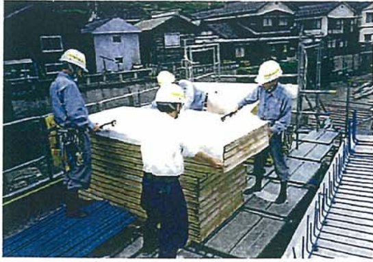
△ 透水性型枠 (布張り製作)
