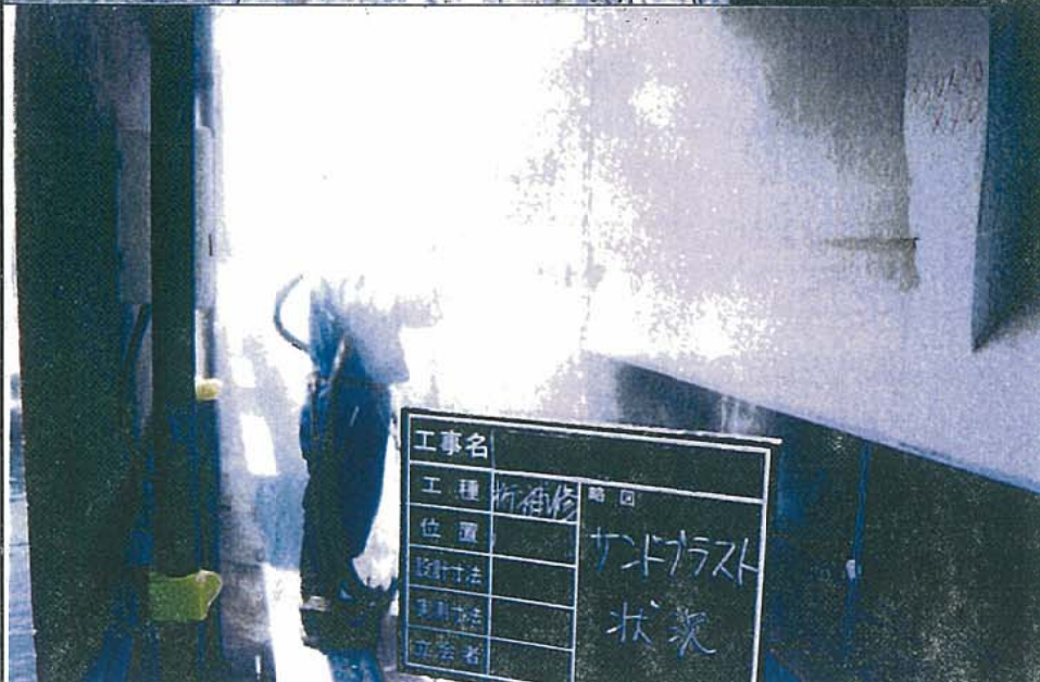
主桁下フランジ部 サンドブラスト工
