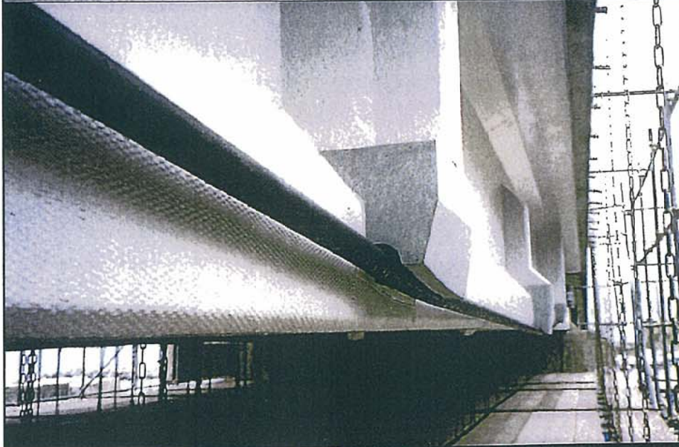
施工完了の外ケーブル
