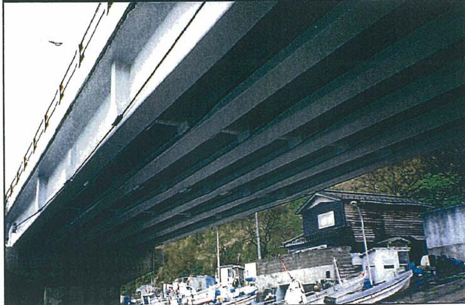
外ケーブルの外観
