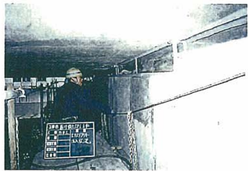
△ 沓座覆工 (リウレン系弾性樹脂注入)
