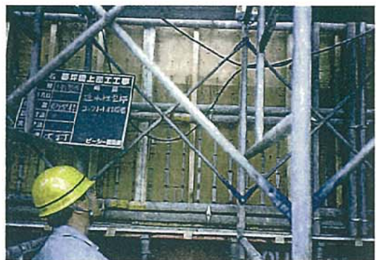
△ 透水性型枠 (脱水状況)
