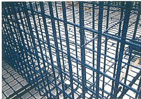
△ 結束線 (鉄筋組立状況)
