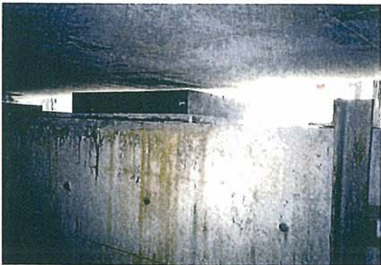
△ 支承 (ゴム支承設置)
