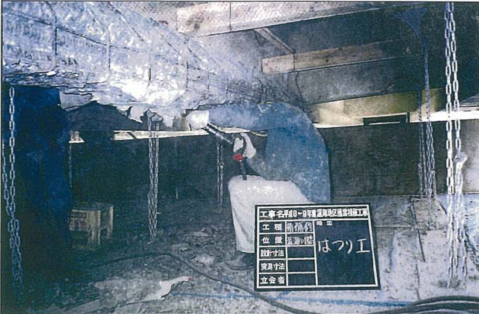
主桁下フランジ部 はつり工
