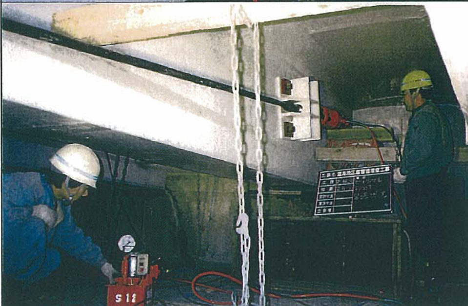
外ケーブルの緊張
