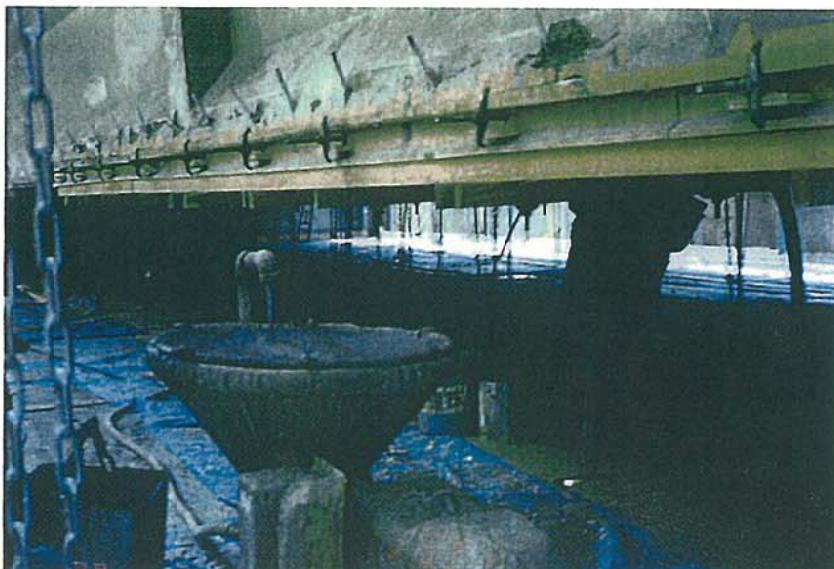
注入パイプ取付け 及びスラリー注入
