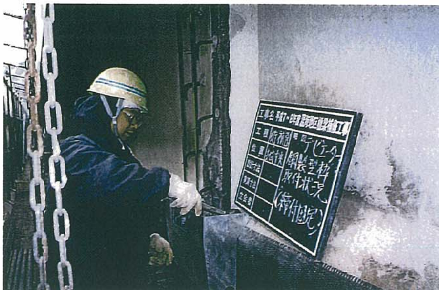
デビエータ 鋼製型枠取付け
