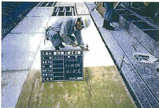
△ 透水性型枠 (組立)
