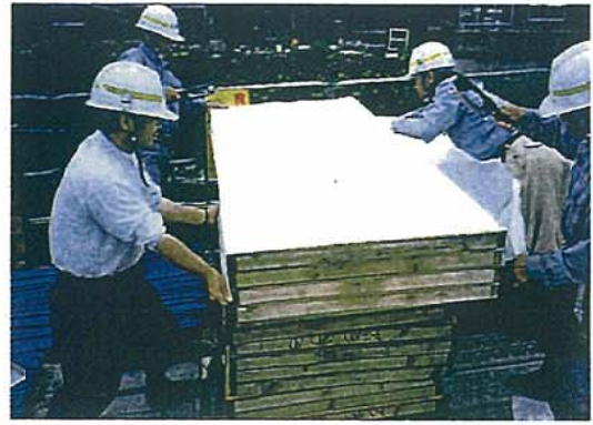
△ 透水性型枠 (布張り製作)
