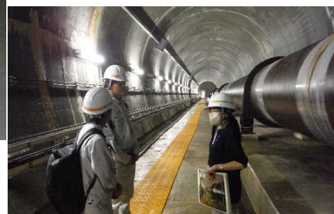
▲ 現場実習 ※七ヶ宿ダム見学
