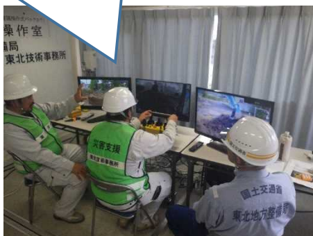
距離が50m以上であれば、モニターで確認しながら室内でバックホウをリモコン操作
