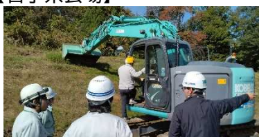
実習(ICT建機)
