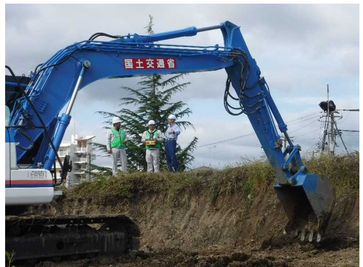
距離が50m以内であれば、目視によりバックホウをリモコン操作
