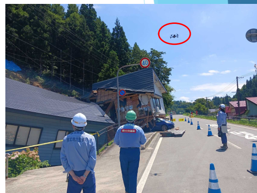
家屋倒壊による現場調査 (山形県舟形町舟形地区)
