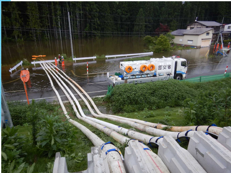
場所:秋田県大仙市協和峰吉川地内 (小平沢排水樋門) 機械:排水ポンプ車(60m 3 /min) 1台 内容:浸水箇所の排水作業 期間:令和5年7月16日～17日
