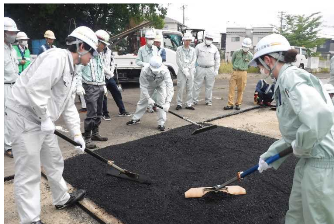
【アスファルト舗装】人力舗装
