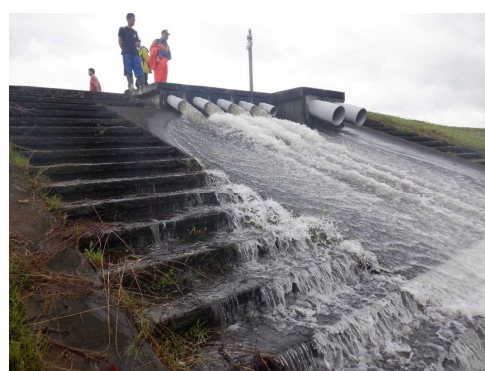
場所:秋田県大仙市強首地内 (強首排水樋管) 機械:排水ポンプ車(30m 3 /min) 1台 照明車 1台 内容:浸水箇所の排水作業 期間:令和5年7月16日～17日
