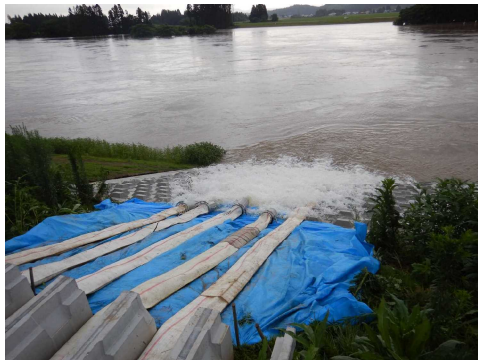
場所:秋田県大仙市協和峰吉川地内 (小平沢排水樋門) 機械:排水ポンプ車(60m 3 /min) 1台 内容:浸水箇所の排水作業 期間:令和5年7月16日～17日
