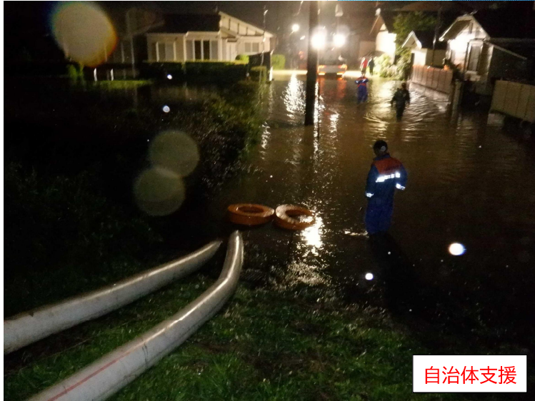
場所:秋田県南秋田郡八郎潟町地内 機械:排水ポンプ車(60m 3 /min) 1台 照明車 1台 内容:浸水箇所の排水作業 期間:令和5年7月15日～16日
