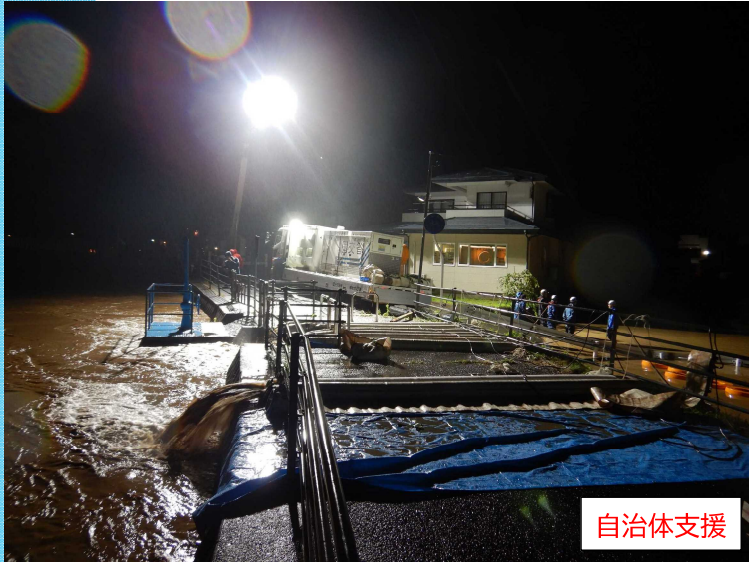
場所:秋田県南秋田郡八郎潟町地内 機械:排水ポンプ車(30m 3 /min) 1台 内容:浸水箇所の排水作業 期間:令和5年7月15日～16日
