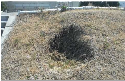
堤防の陥没
