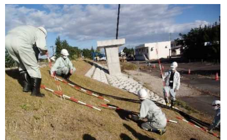
堤防法面のはらみ出しの計測
