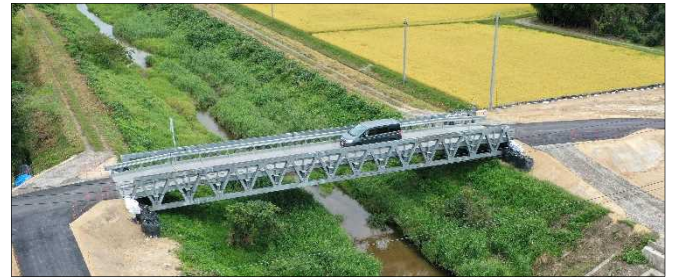
丸山橋に設置している応急組立橋
