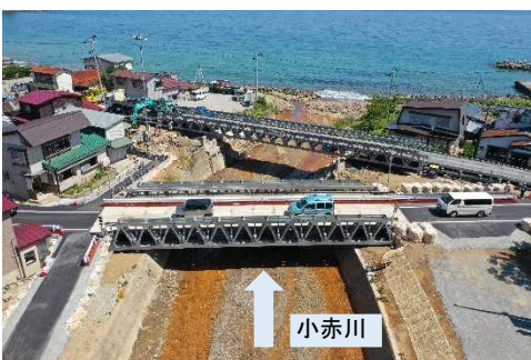
応急組立橋2橋が同時にかかる災害復旧現場（R4. 6. 21撮影）
