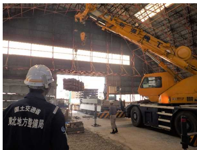
応急組立橋積込状況（東北技術事務所 応急橋梁格納庫）
