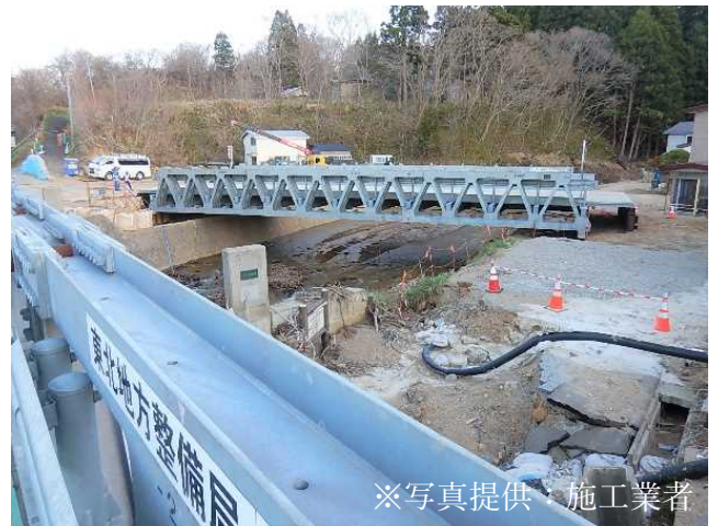
応急組立橋設置完了（R4. 4. 23 15時30分）
