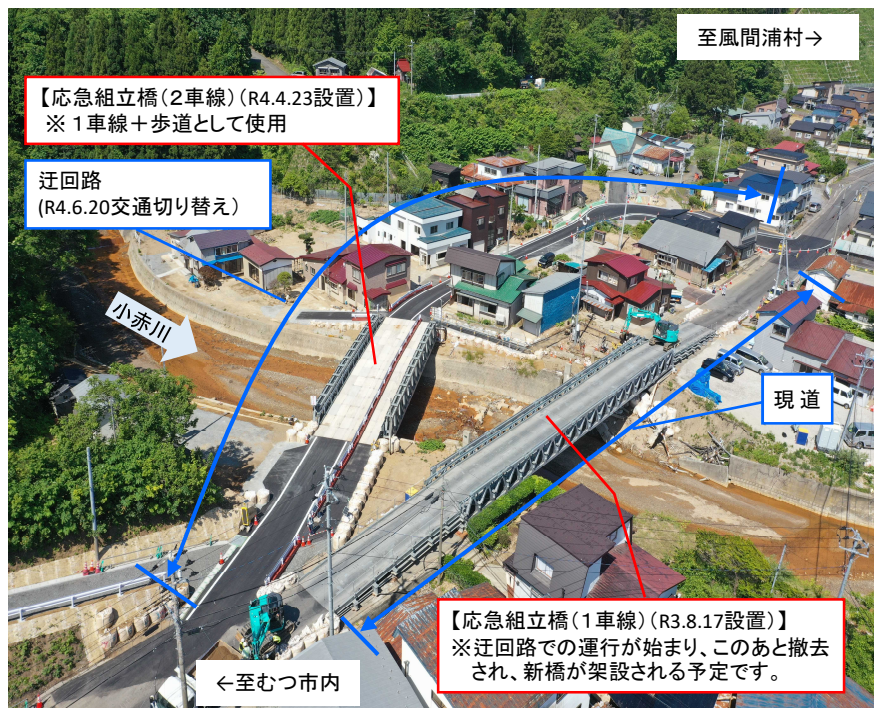
応急組立橋2橋が同時にかかる災害復旧現場（R4. 6. 21撮影）
