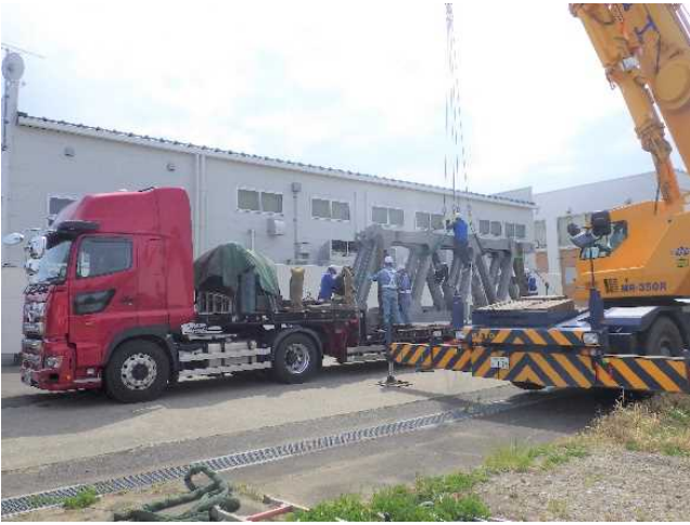
応急組立橋積込状況（35tクレーン）
