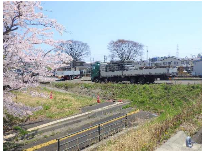
応急組立橋搬出完了（R4. 4. 20 12時）
