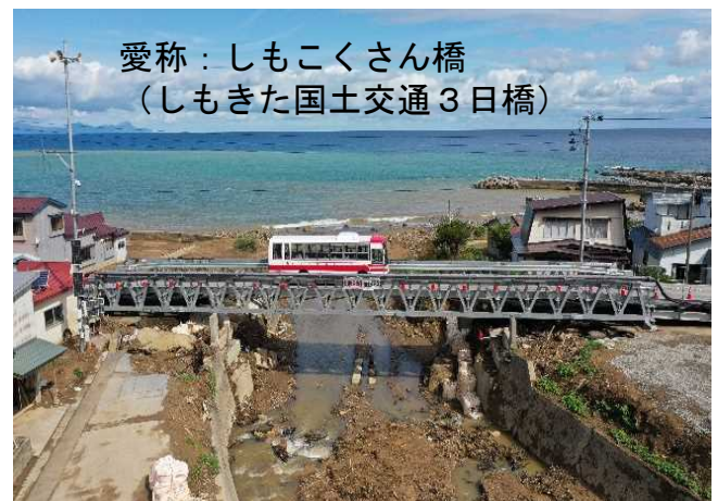
応急組立橋（1車線）設置状況（R3. 10撮影）
