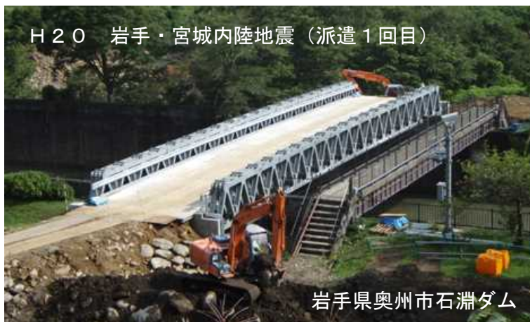
応急組立橋（2車線）
