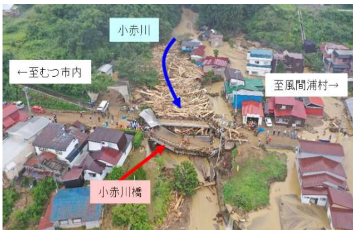
国道279号 小赤川橋被災状況（R3. 8. 11）
