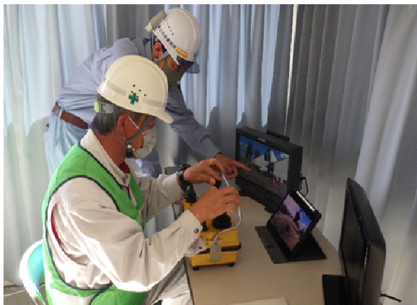
▲モニターを見ながらの遠隔操作 (土砂掘削作業)
