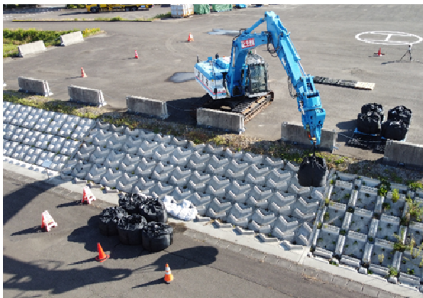
▲大型土のう設置作業
