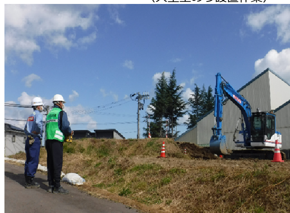
▲土砂掘削作業
