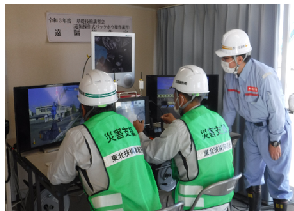
▲モニターを見ながらの遠隔操作 (大型土のう設置作業)
