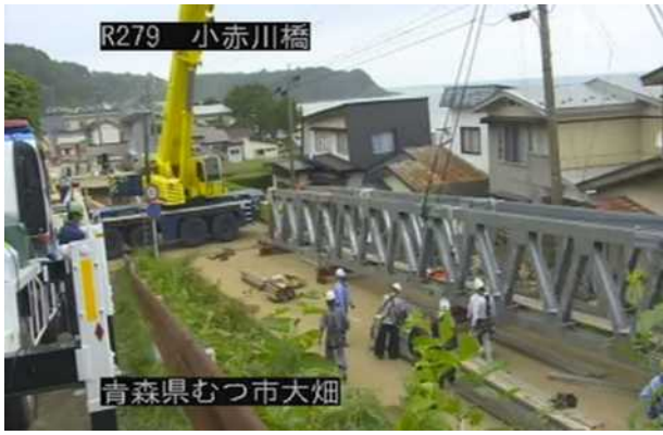
応急組立橋組立状況
