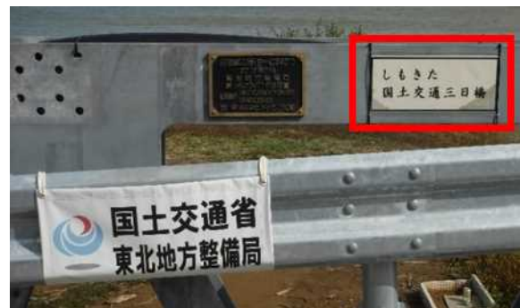
主桁に「しもきた国土交通三日橋」
