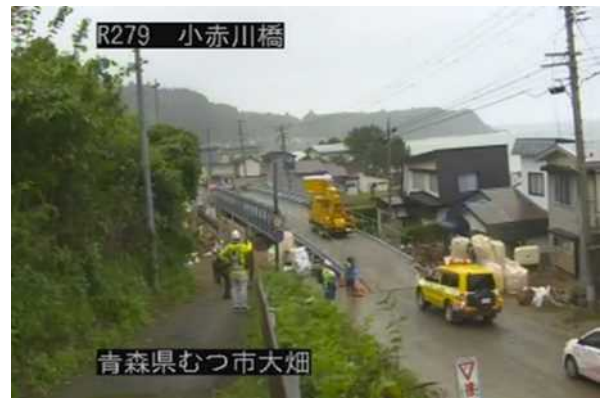
応急組立橋開通（17日16時）
