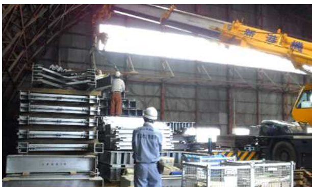
応急組立橋積込状況（35tクレーン）
