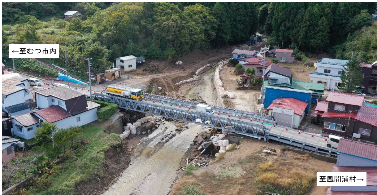
応急組立橋供用状況（令和3年10月6日撮影）
