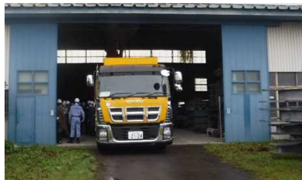
応急組立橋組立積込状況
