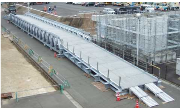
応急組立橋全景
