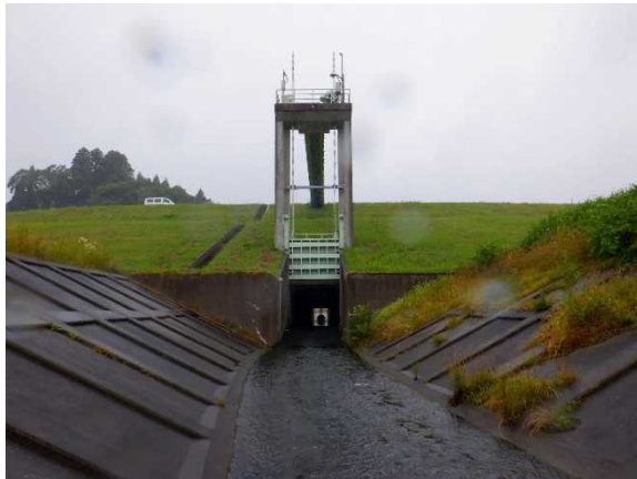
▲排水樋門全景
