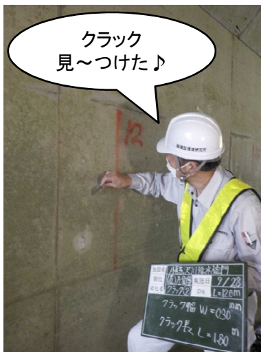
▲排水樋門内のクラック計測
