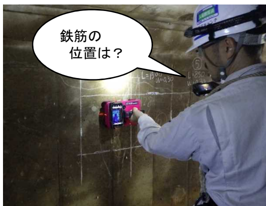
▲樋門の鉄筋探査状況
