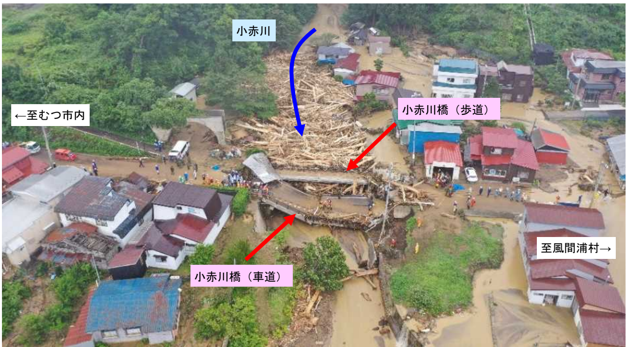
被災状況（国道279号 小赤川橋）
