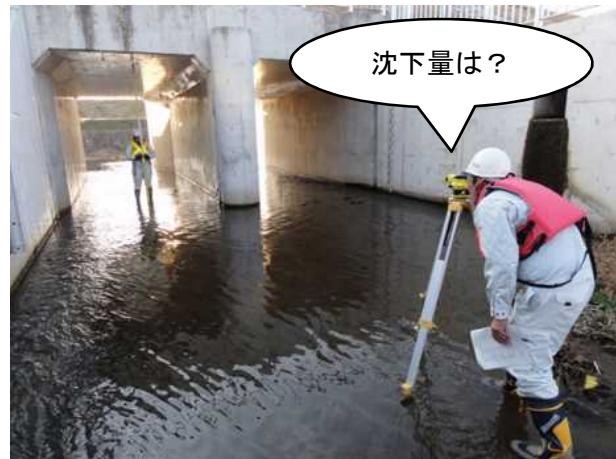
▲排水樋門内の沈下量計測
