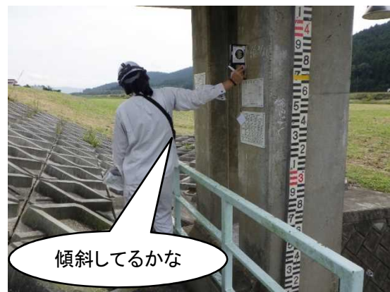
▲門柱の傾倒計測
