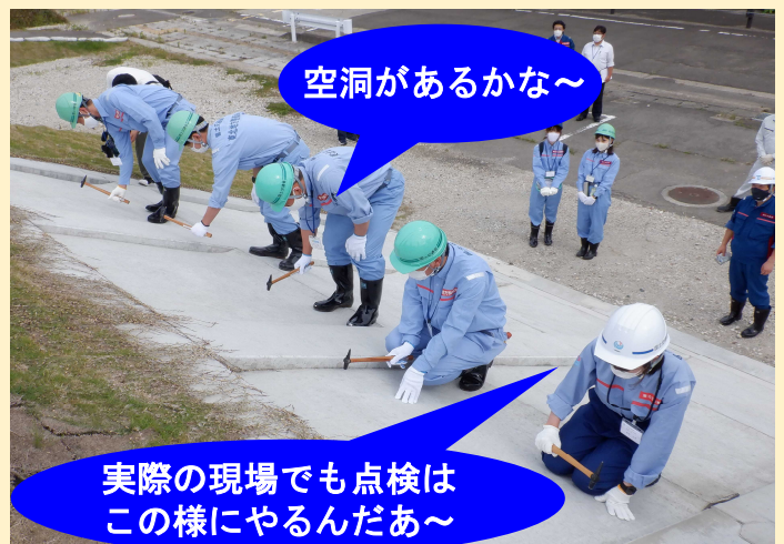
護岸の打音調査
