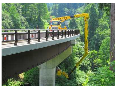
【橋梁点検車(バケット式)】 交通規制を行い、橋梁診断員による橋脚の点検
