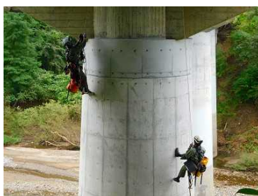
【ロープアクセス点検】 高い橋脚など点検車による実施が困難な箇所は人力で点検
