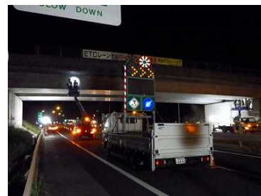
【他工事の規制に合わせ実施】 自動車専用道路の工事規制と一体で行い規制区間を短縮
