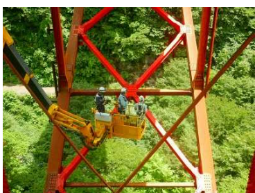
【橋梁点検車(バケット式)】 トラス橋は、橋の部材と機械の接触を回避しながら点検
