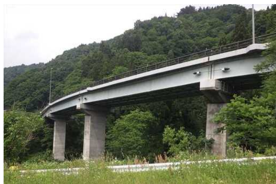
高橋脚の橋梁で活用
