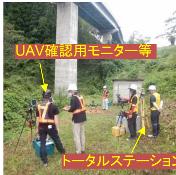
U A Vを用いた点検状況
