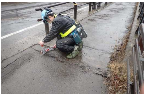
【郡山国道事務所管内の調査】
