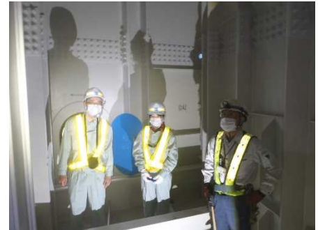
橋梁点検現地実習
