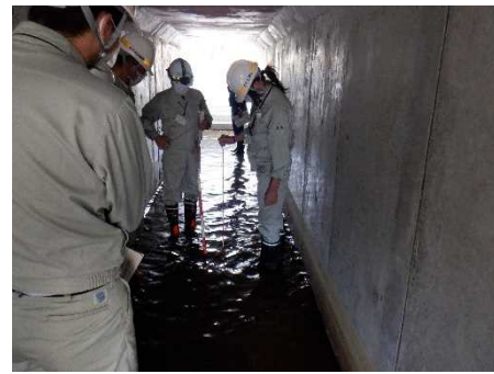
▲ 樋門函体の沈下量計測
