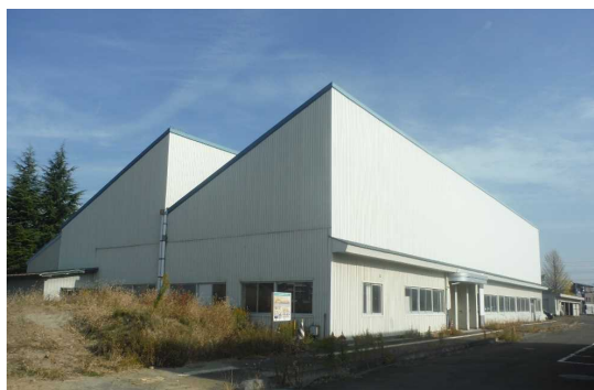
解体を待つ現在の旧展示館
