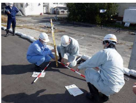
▲ 抜け上がりの計測
