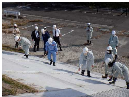
▲ 打音による護岸の空洞化確認
