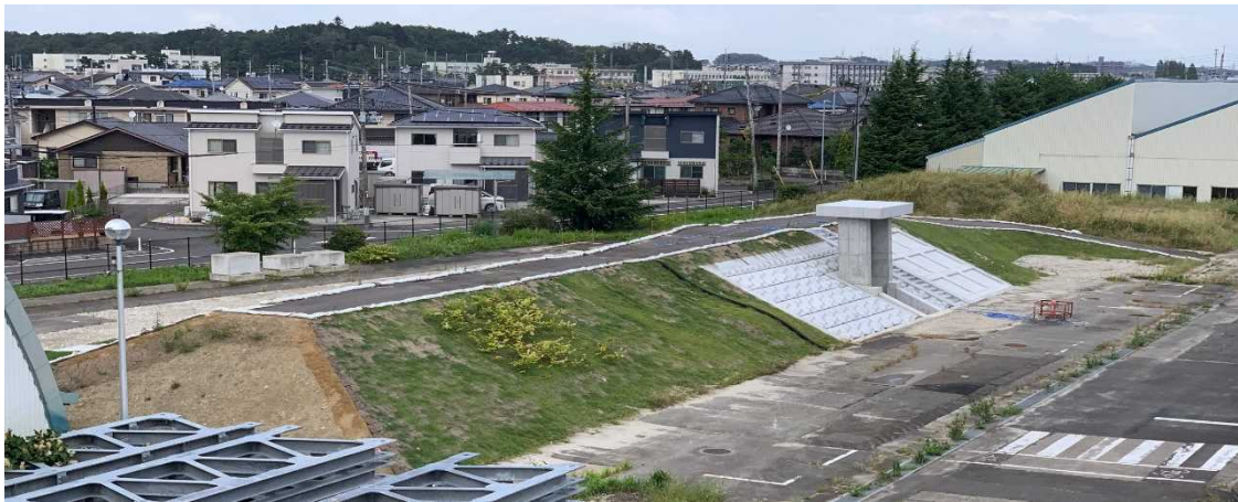
▲研修用堤防の全景
