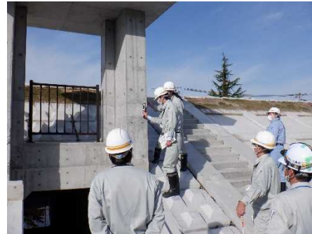
▲ 樋門門柱の傾倒計測
