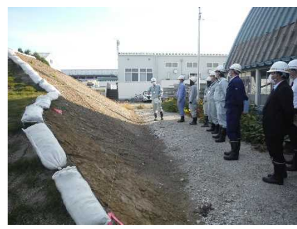
▲ 堤防開削断面の確認
