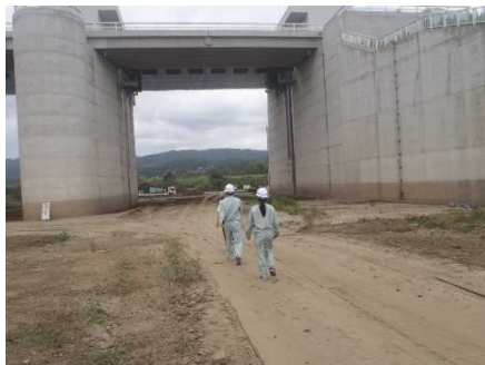
河川管理施設点検現地実習
