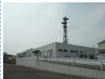
現在の アスファルト試験棟
