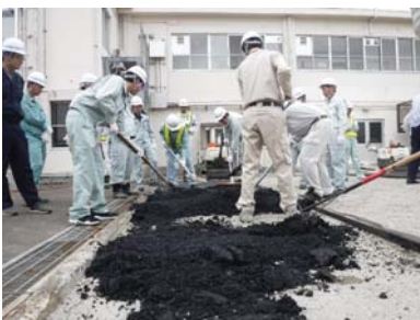
▲アスファルト基礎技術講習会:実習(H30.7.4)
