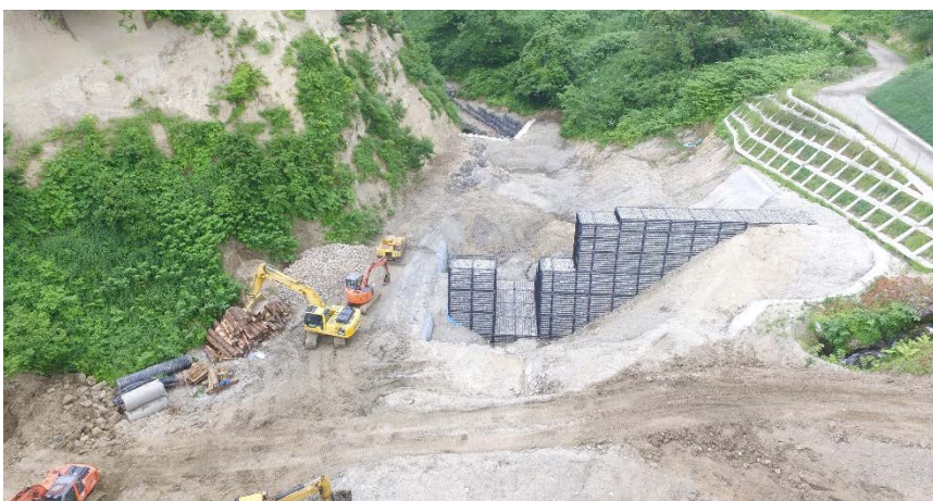
赤砂第一砂防堰堤の施工状況
