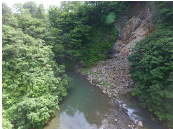
川岸の崩落箇所
