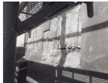
施工前・後状況
