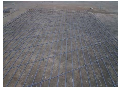
鉄筋組立完了
