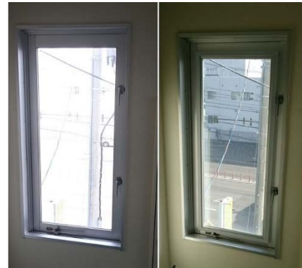
縦すべり窓 施工前後
