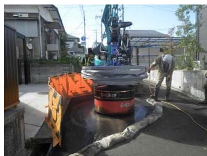
円形カッター切断状況
