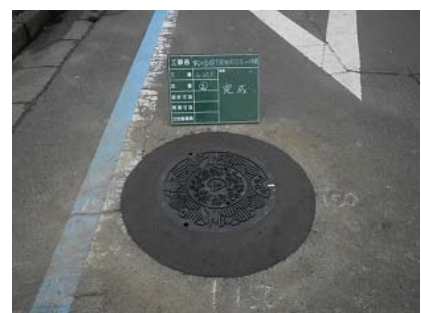
施工完了状況
