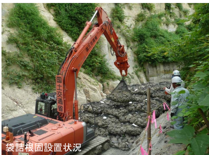
大型土のう設置装置による袋詰根固設置状況
