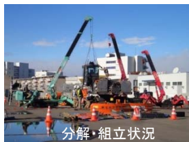
分解・組立状況
