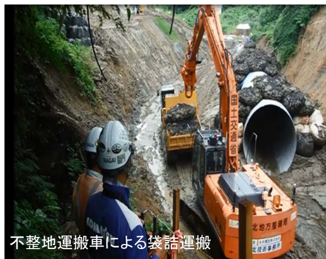
大型土のう設置装置による袋詰根固設置状況
