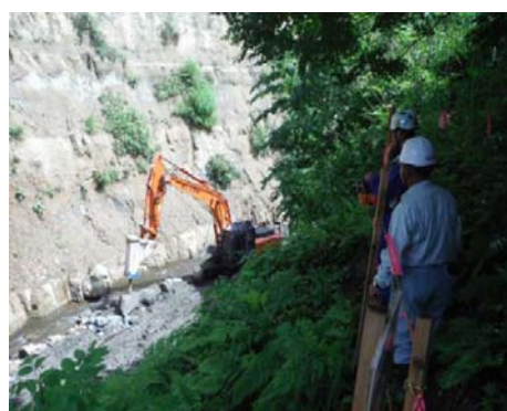
ブレーカーによる転石小割り状況と操縦者
