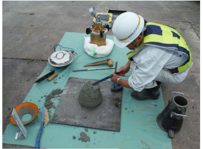
▲スランプ試験状況
