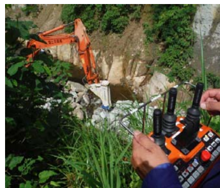
ブレーカーによる転石小割り状況と操縦者
