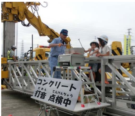
橋梁点検車上でコンクリート点検
