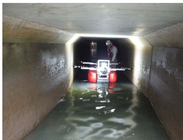
排水樋門内の点検イメージ
