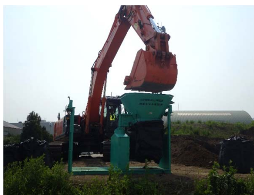
④完成した大型土のうを移動後、新しい大型土のう袋を設置する(①の手順に戻る)
