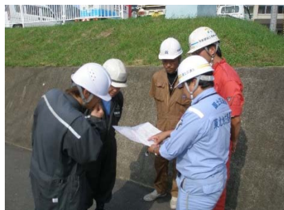
災害対策機械設置箇所指示
