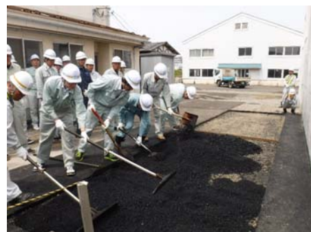
▲アスファルト舗装技術講習(H29.6.30)
