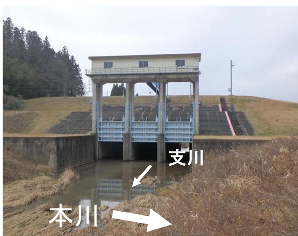
排水樋門全景
