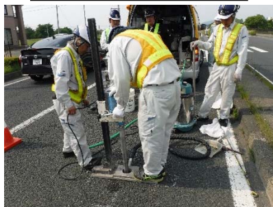
空洞可能性箇所の穴開け
