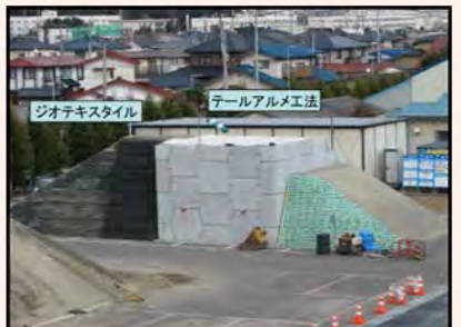
補強土壁工
