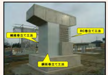
橋脚耐震補強工
