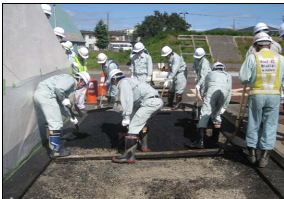
アスファルト舗装体験(イメージ)
