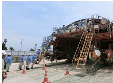
▲セントル(トンネル用の型枠)の説明
